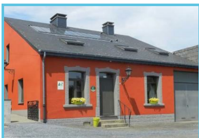
La Fermette - Vue de la façade avant
